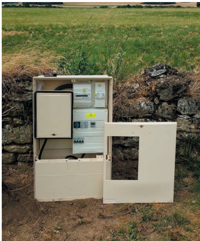
Exemple d'application pour un coffret REMIC 450 avec CIBE intégré :
