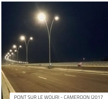
PONT SUR LE WOURI - CAMEROON | 2017
